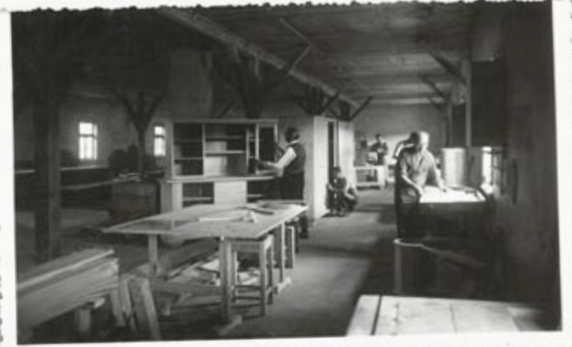
Von Flüchtlingen und Heimatvertriebenen bewohnte Baracke im ehemaligen „Vorlager“; 1949/50
